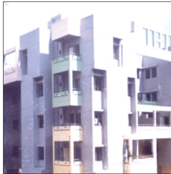
Ahmedabad : 310 DUs Completion Year : October, 2005
